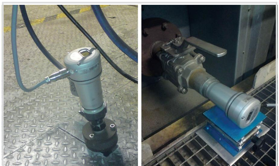
Bild 2. Typische Installationen von Flammenwächtern (links Brennkammerdecke und rechts Dampferzeugerwand).
